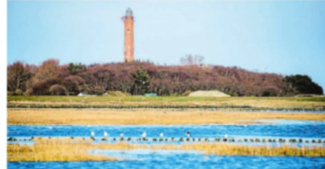
Die Stromkabel sollen Norderney (im Bild) und Baltrum unterqueren. Die Arbeiten starten in diesen Tagen.
