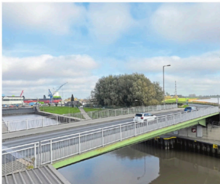
Bei der Schleusenbrücke in Leer müssen Sanierungsarbeiten an der Fahrbahn vorgenommen werden.
