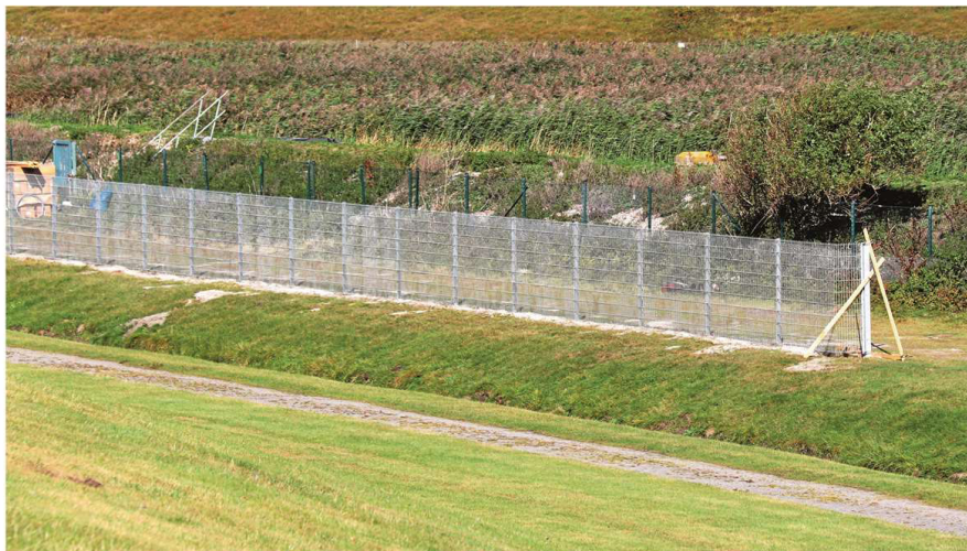
Neuer funktionaler Zaun entlang der Vererdungsbeete am Klärwerk.
