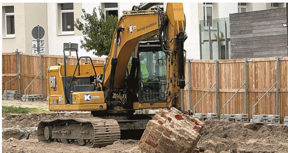
Die Erdarbeiten für den Hotelneubau an der Weststrandstraße haben begonnen.
