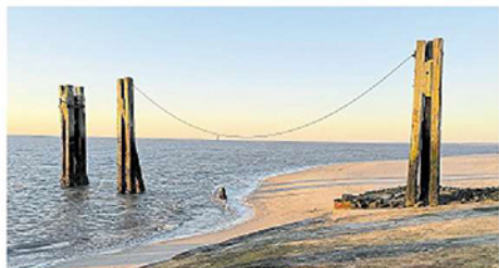
Ein Exemplar der ehemals acht Dalben ist der Belastung bereits zum Opfer gefallen.
