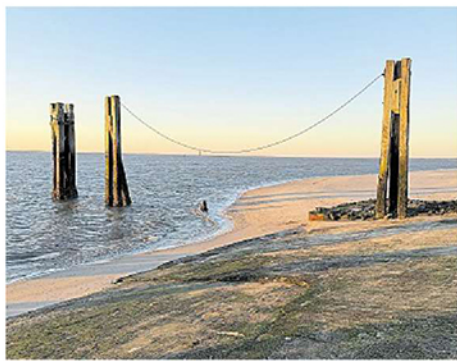
Ein Exemplar der ehemals acht Dalben ist der Belastung bereits zum Opfer gefallen.
