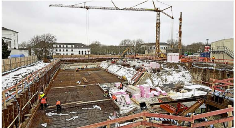
Alle Vorbereitungsmaßnahmen sind abgeschlossen und der Beton kann kommen.
