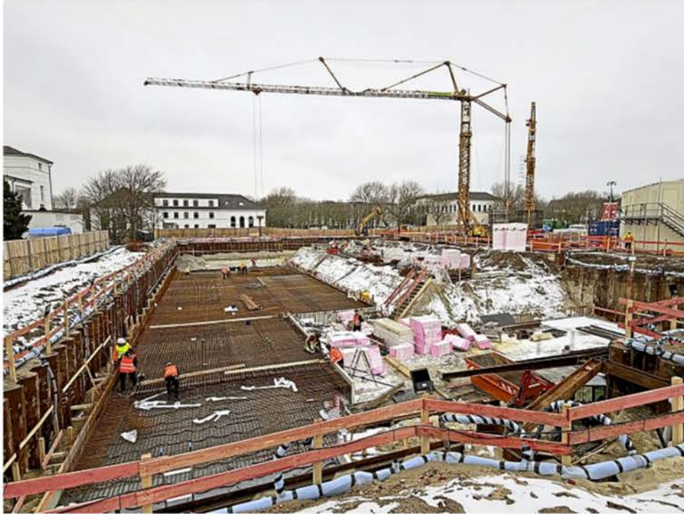
Alle Vorbereitungsmaßnahmen sind abgeschlossen und der Beton kann kommen.
