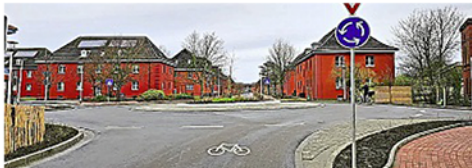
Jetzt stehen die Termine der verkehrsarmen Phasen auf der Insel fest.
