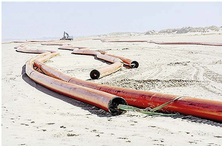
Während der Saison will Amprion wieder Kabelschutzrohre am Norderneyer Nordstrand verlegen.
