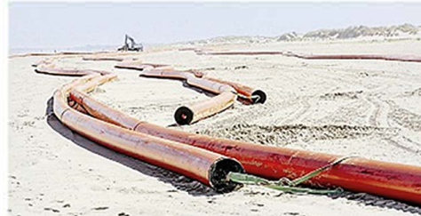
Während der Saison will Amprion wieder Kabelschutzrohre am Norderneyer Nordstrand verlegen.
