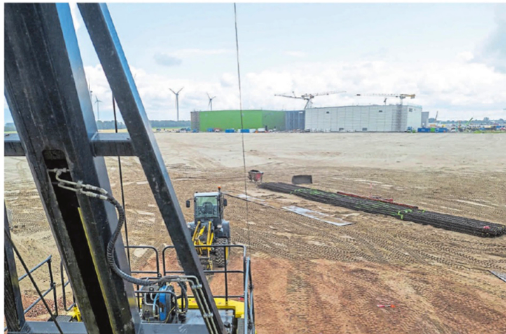
Der Baugrund für eine Wasserstoff-Produktionsanlage. Der Oldenburger Energieversorger EWE plant auf der Fläche einen Elektrolyseur zu bauen, die derzeit größte Anlage dieser Art in Deutschland.
