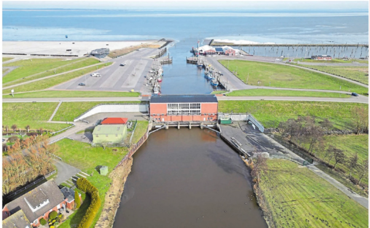
Blick auf das Siel und Schöpfwerk Accumersiel: Um sich für drohende Hochwasser zu wappnen, will Niedersachsen Deiche erhöhen und alte Schöpfwerke modernisieren.
