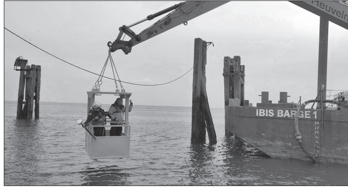
An der Schwerlastrampe am Weststrand sollen bis zum Sommer die Dalben ausgetauscht werden. Foto: Linke
