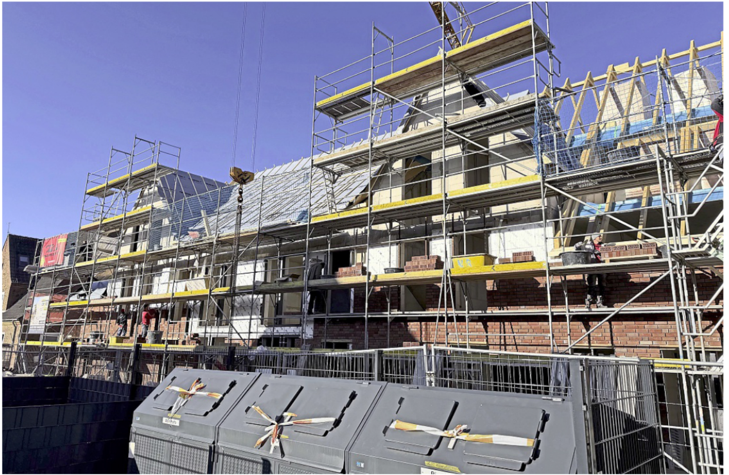
Die Giebel für das neue Personalwohnhaus im Mühlenquartier stehen bereits und das Richtfest kann beginnen.
