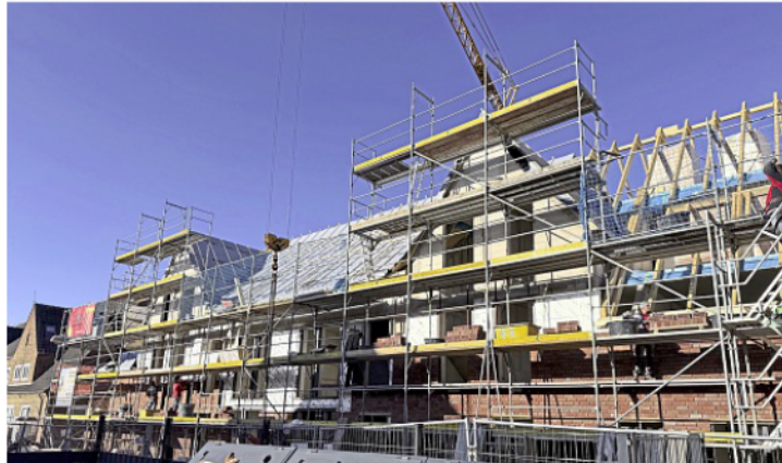
Die Giebel für das neue Personalwohnhaus im Mühlenquartier stehen bereits und das Richtfest kann beginnen.
