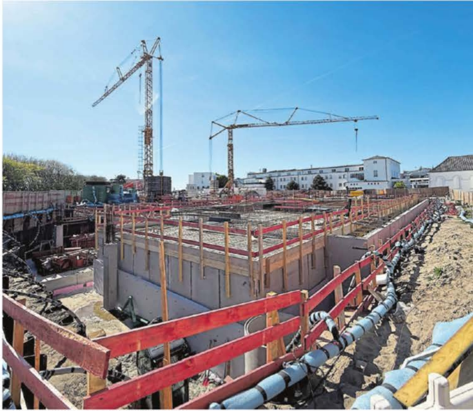
Der Bau des Hotels „Luv“ kommt sichtbar voran.
