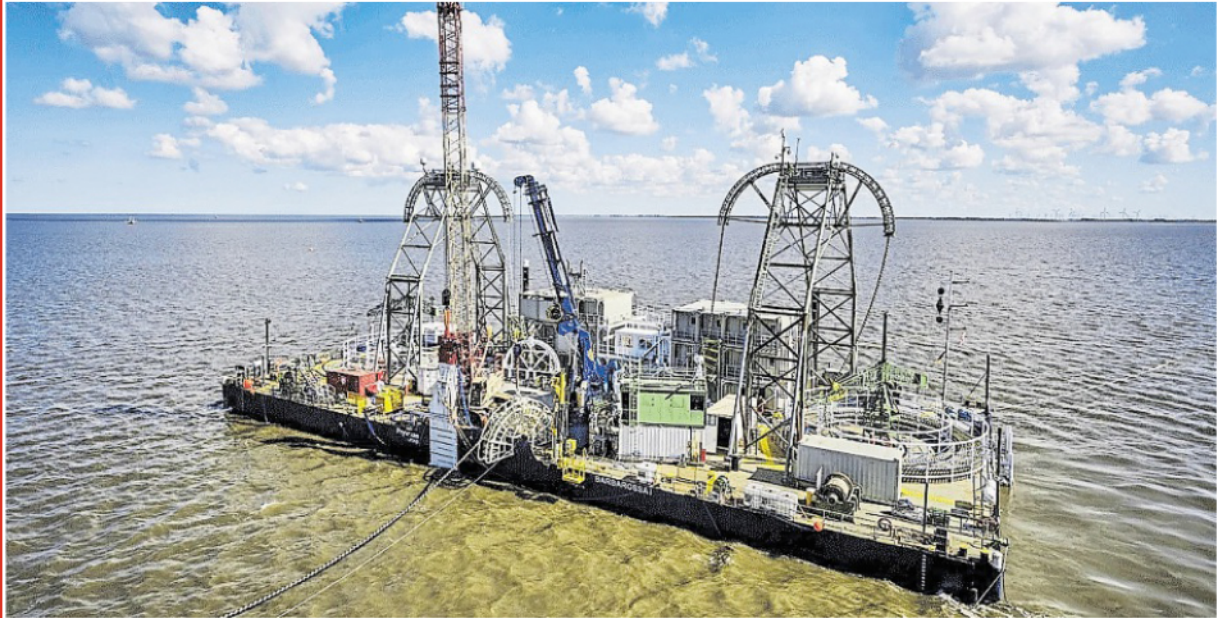
Die Verlegebarge „Barbarossa 1“ liegt zum Ende der Kabelarbeiten am Strand.
