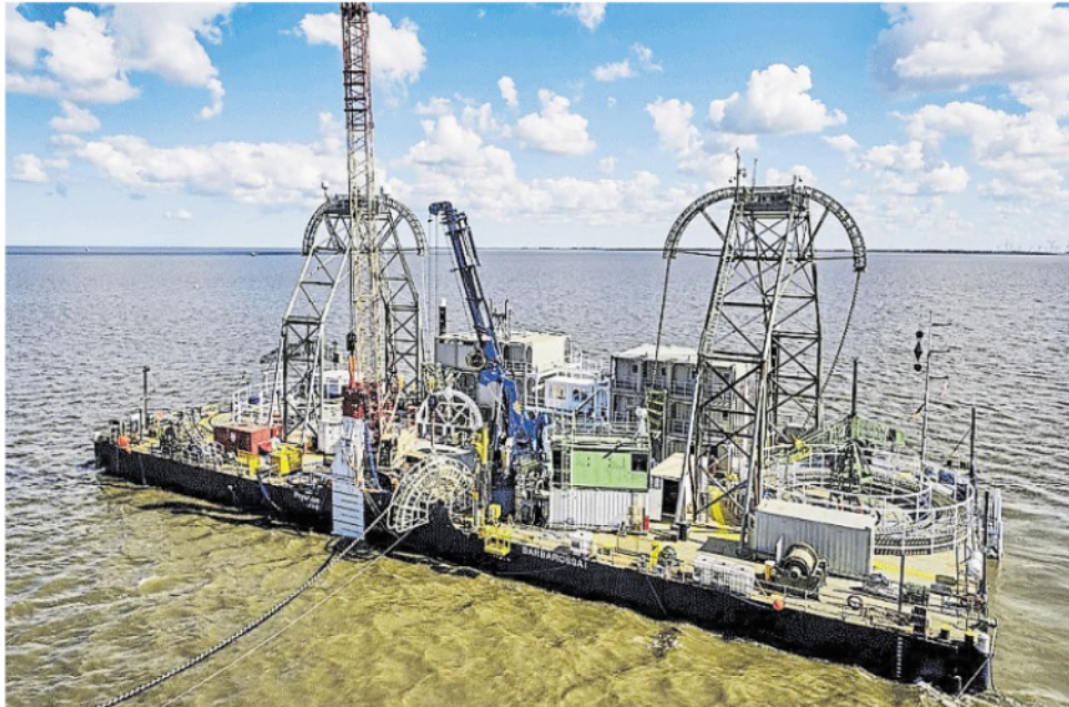
Die Verlegebarge „Barbarossa 1“ liegt zum Ende der Kabelarbeiten am Strand.
