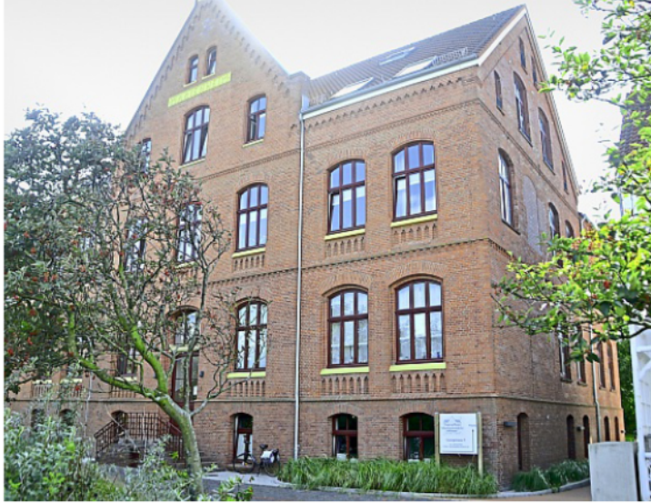
Das Marienheim in Norderney. Zur Sicherung der Pflegefunktion wurde eine Veränderungssperre für das Gebiet beschlossen. Foto: Sven Bohde (bos)
