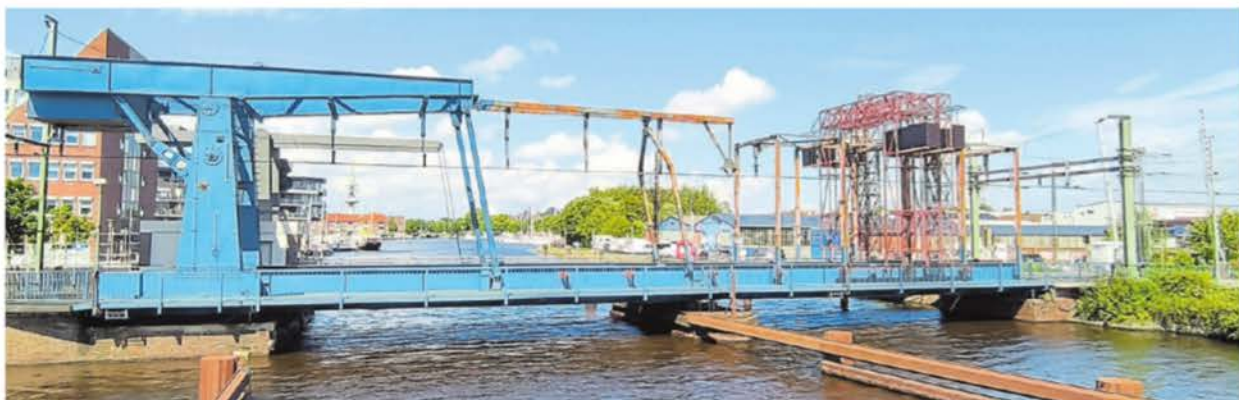
Sorgenkind: Die Klappbrücke für den Zugverkehr in Emden ist in die Jahre gekommen. Wegen einer Sanierung fällt der Betrieb für drei Wochen aus. Zugverkehr und Schifffahrt werden eingestellt.
