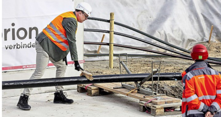
Wie geschmiert: Christian Meyer, Niedersächsischer Minister für Umwelt, Energie und Klimaschutz, packt am Rande der Energieministerkonferenz auf der Amprion-Baustelle beim Kabeleinzug mit an.
