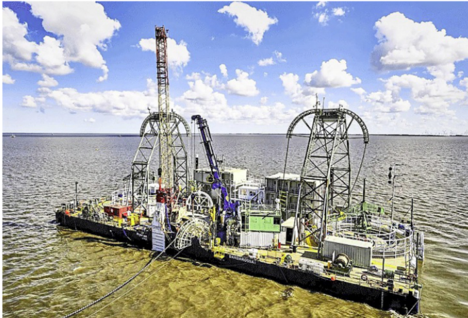
Die Verlegebarge „Barbarossa I“ liegt zum Ende der Kabelarbeiten am Strand.
