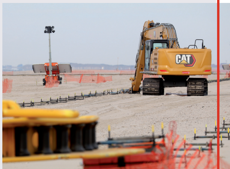
Verlegearbeiten am Oase-Strand.
