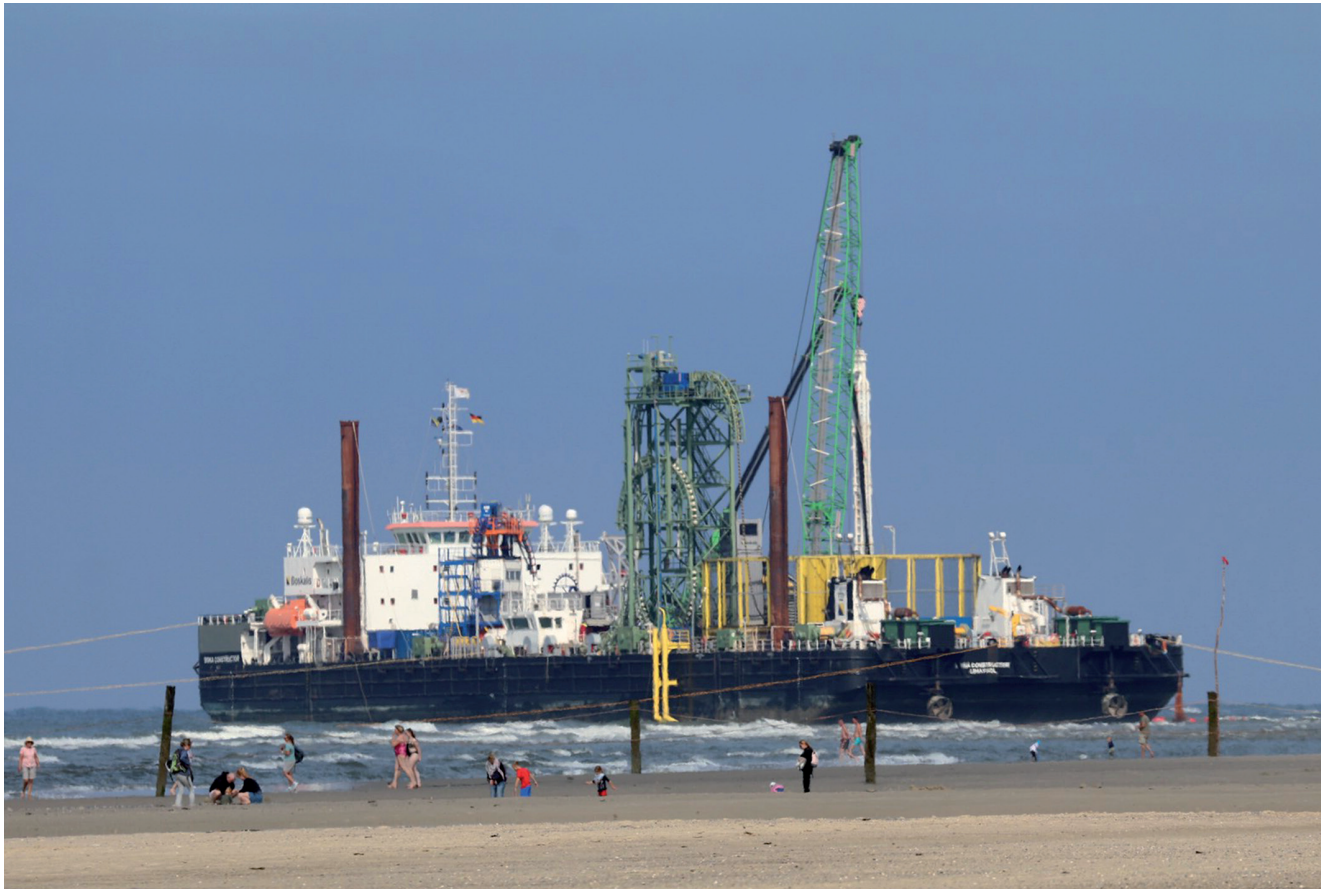
Die Verlegebarge „Barbarossa“ wie sie zuletzt vor dem Oase-Strand positioniert war.
