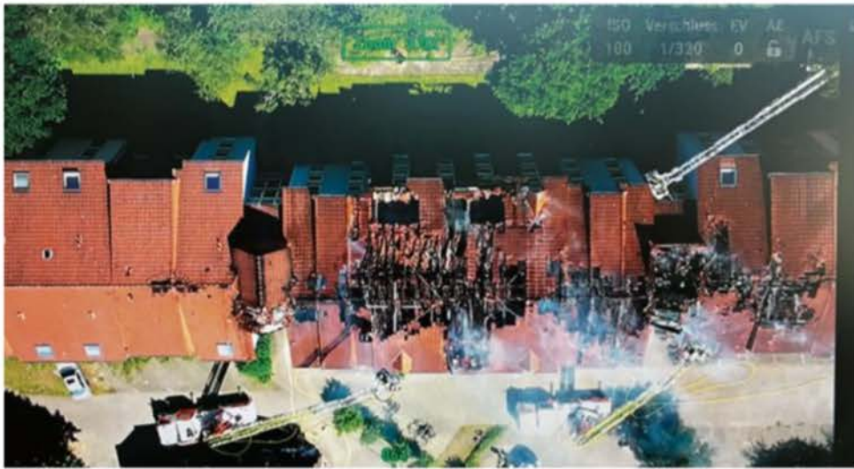
Diese Luftaufnahme zeigt: Der Dachstuhl ist auf einer Länge von über 100 Metern zerstört.
