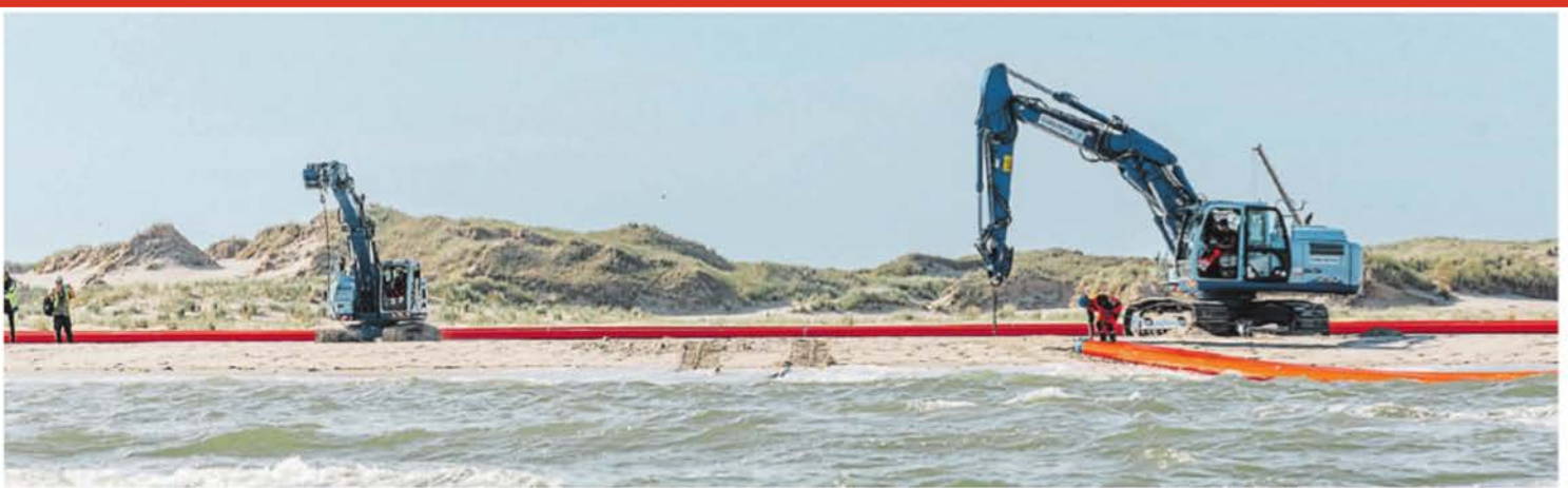
Zeitweise werden in diesem Sommer Strandabschnitte auf Norderney gesperrt: Amprion zieht neue Leitungen durch die Insel.
