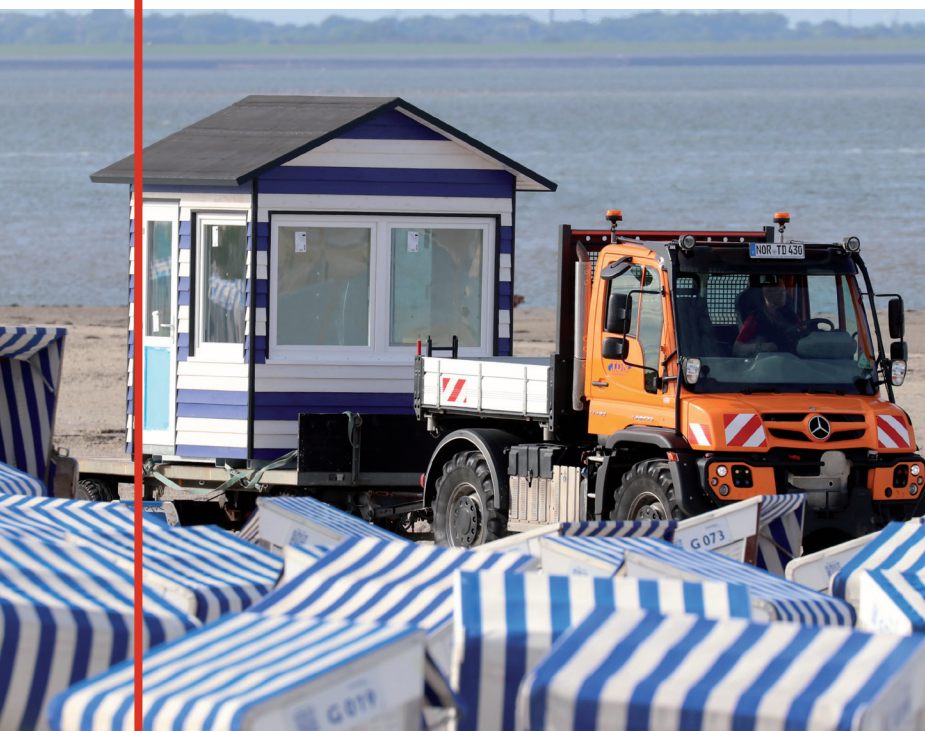
Die Technischen Dienste Norderney (TDN) lieferten die neue Schutzhütte für die Rettungsschwimmer an den Weststrand.
