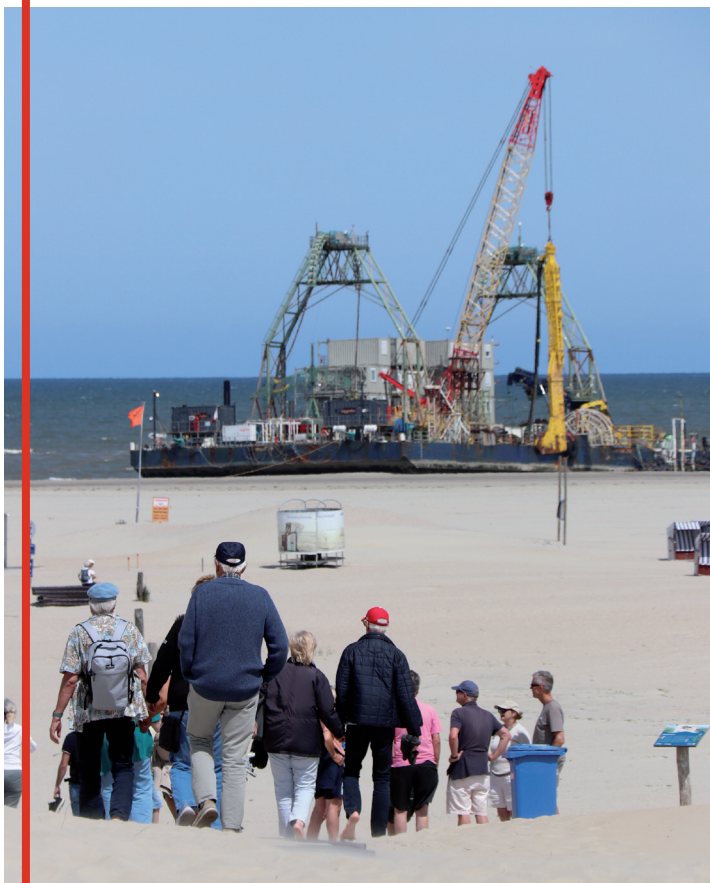
Einige sehen die Arbeiten vor Ort am Strand mit der Verlegebarge Barbarossa I als zusätzliches touristisches Highlight und pilgern an den Strand im Inselosten.
