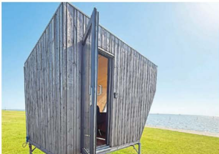
Direkt hinter dem Deich in Schillig steht der neue Tiny Work Space der Wangerland Touristik.
