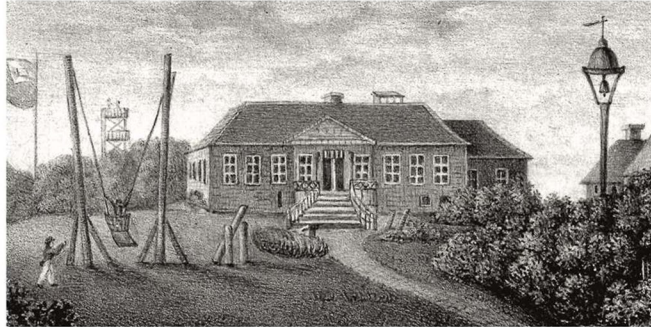
Ansicht des Conversationshauses von Norden mit dem zwischen 1816 bis 1819 geschaffenen Vorbau und der Freitreppe. Fotos: Archiv der Stadt Norderney
