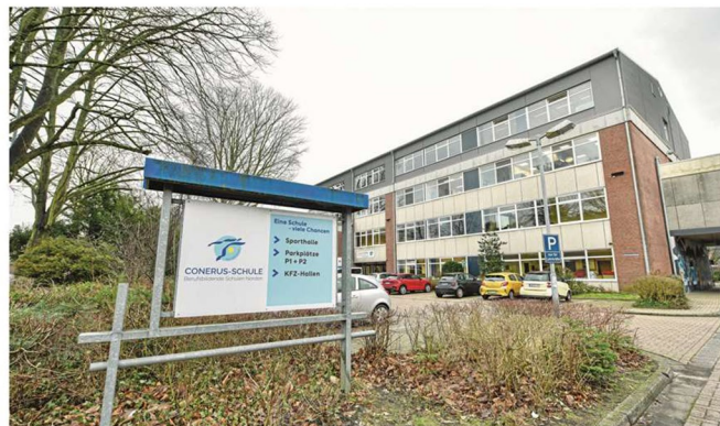
Ein Gebäude der Conerus-Schule soll abgerissen und durch einen Neubau ersetzt werden.
