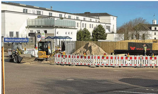
Noch passiert wenig auf Norderneys Großbaustelle an der Weststrandstraße. Aber das hat seine Gründe. Foto: Nour
