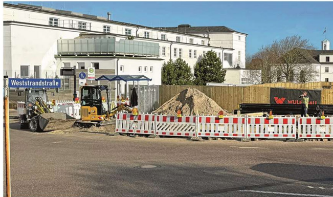
Noch passiert wenig auf Norderneys Großbaustelle an der Weststrandstraße. Aber das hat seine Gründe. Foto: Noun
