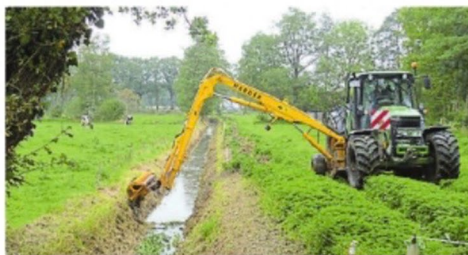
Dafür, dass Gräben regelmäßig gereinigt werden, sorgen Unterhaltungsverbände wie die Sielacht Stickhausen.
